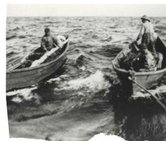
Les doris, utilisés autrefois par les terre-neuvas, sont en bois à fond plat et dotés de bordés à clin, avec une proue pointue. Ils permettaient l'échouage aussi bien sur le sable que sur les galets.
